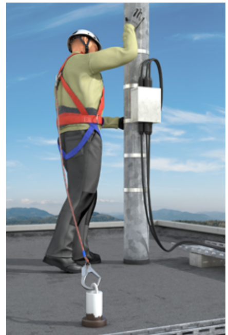
Abb. 17 Beispiel für ein Rückhaltesystem mit fester Länge
