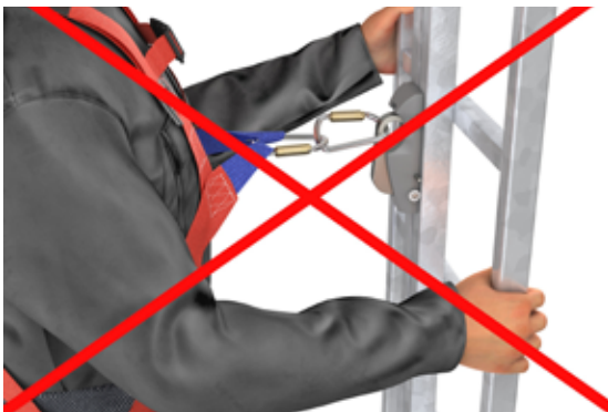
Abb. 77 Unzulässige Verlängerung der Zwischenverbindung mit einem Karabinerhaken
