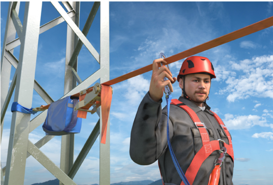
Abb. 67 Beispiel für eine nicht dauerhaft befestigte Anschlageneinrichtung vom Typ C DIN EN 795 (LifeLine)
