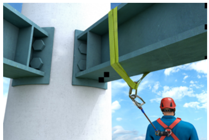
Abb. 58 Beispiel einer temporär genutzten Anschlagmöglichkeit (Stahlträger)
